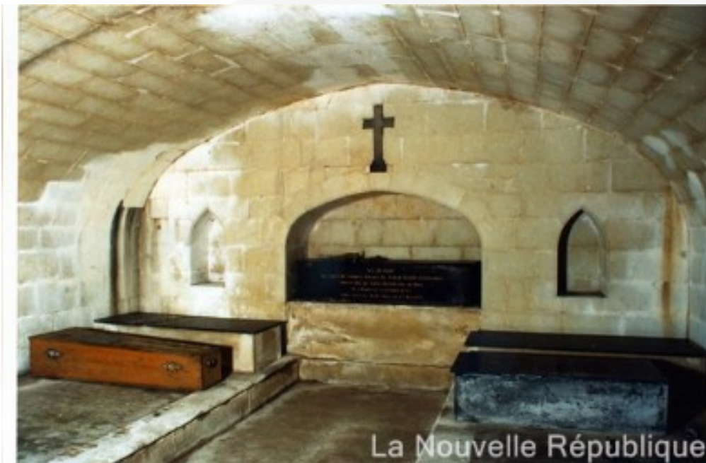
La crypte, difficile d'accès, abrite actuellement huit cercueils au total. Le sarcophage de Talleyrand est jusqu'ici dans la cavité centrale.
